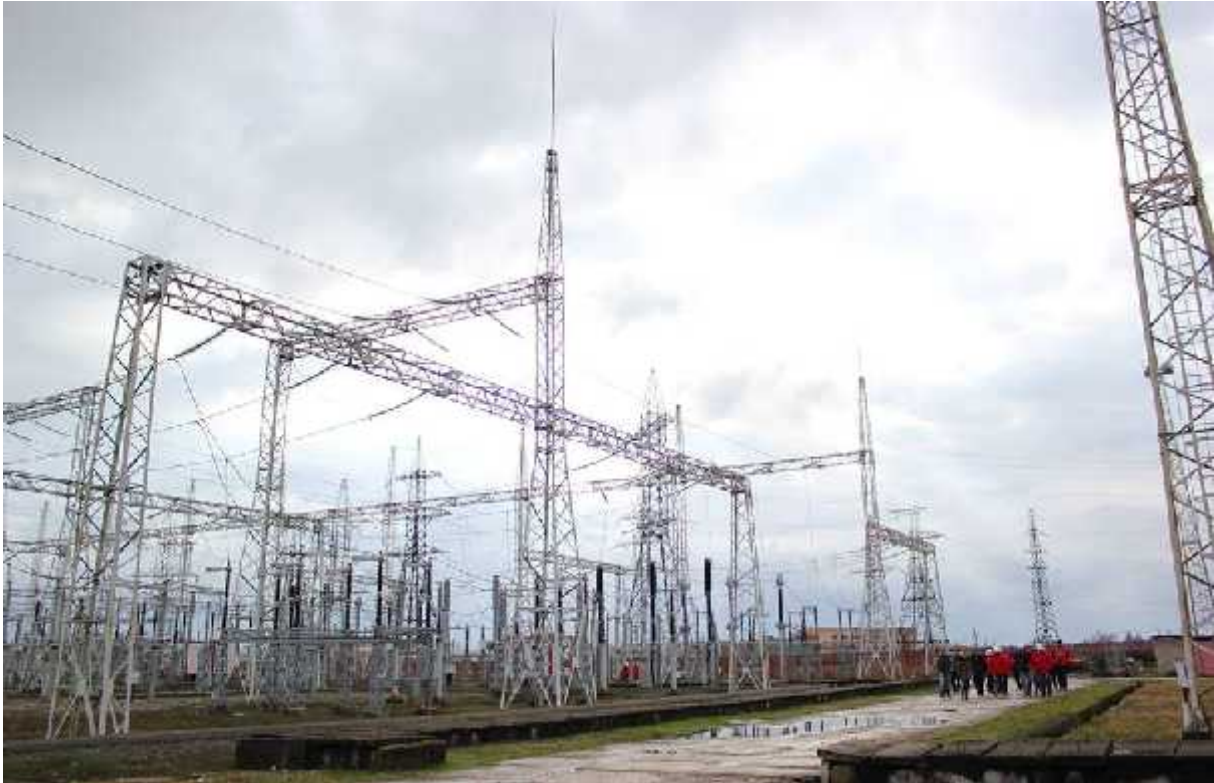
სსე., 2016. ქვესადგურის „ხორგა“ მშენებლობა უწყვეტ რეჟიმში მიმდინარეობს.
